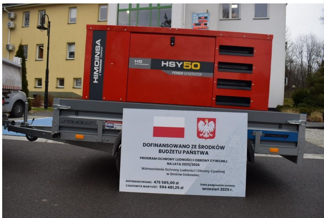
Zdjęcie 10. Zakupiony agregat w ramach OC i OL.
