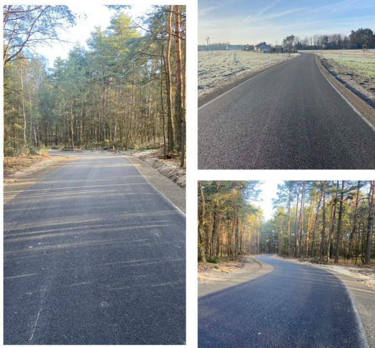
Zdjęcie 1. Modernizacja dróg na terenie Gminy Dzikowiec.
